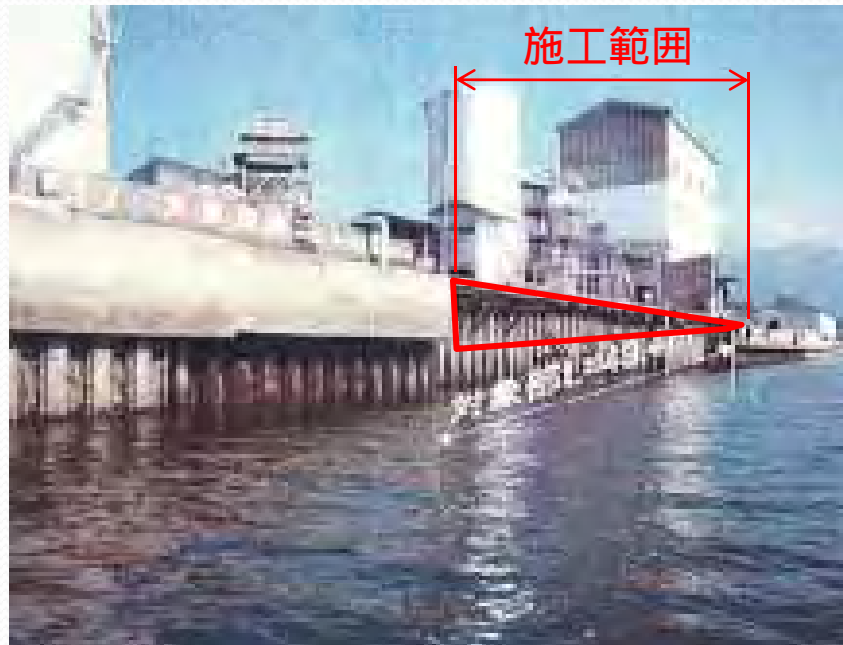
某工場船着場護岸 改修範囲
