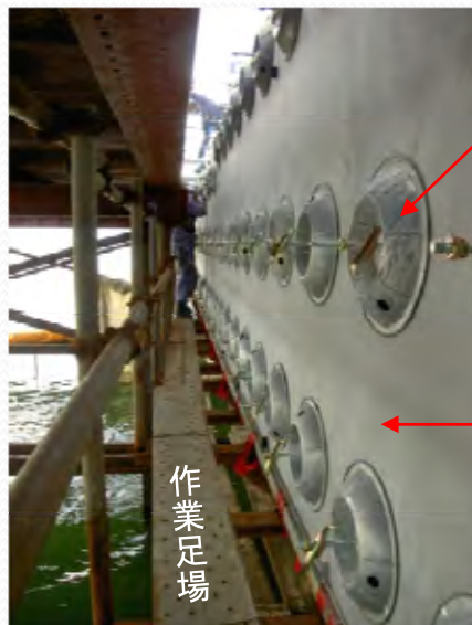
ドーム型支保工材設置(ボード自立)
