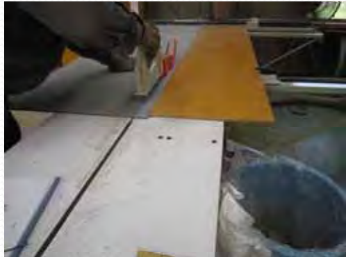
樹脂含浸スモースボード現場切断
