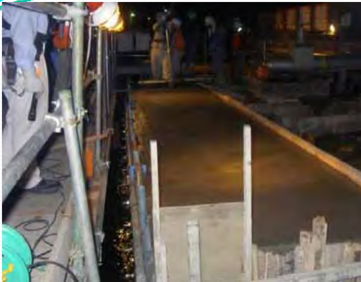
コンクリート打設状況
