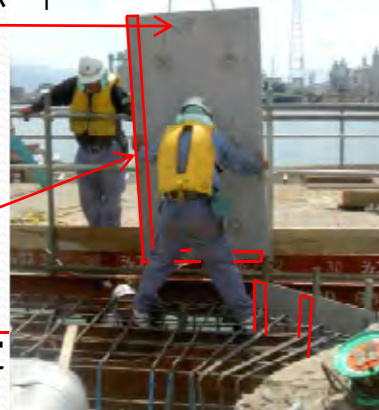
狭隘部のボード設置
