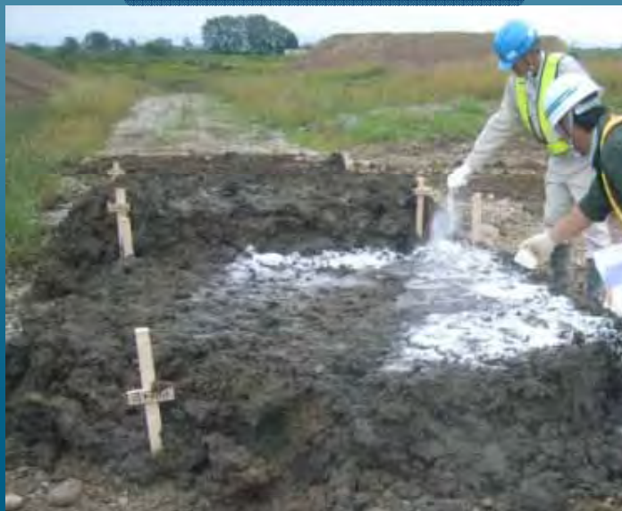
生石灰散布状況
