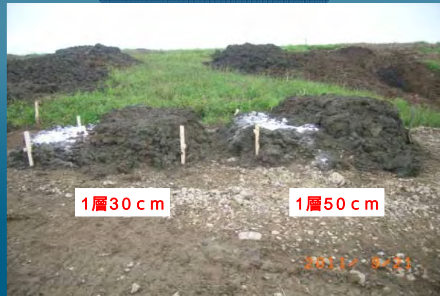
確認試験施工用盛土
