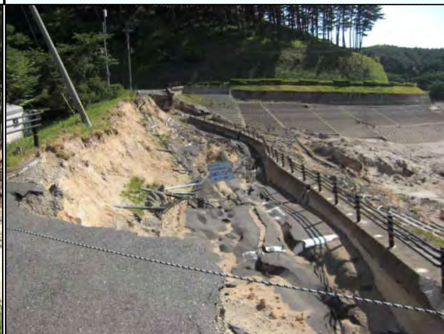
円弧滑り(現地発生土にて築堤)
