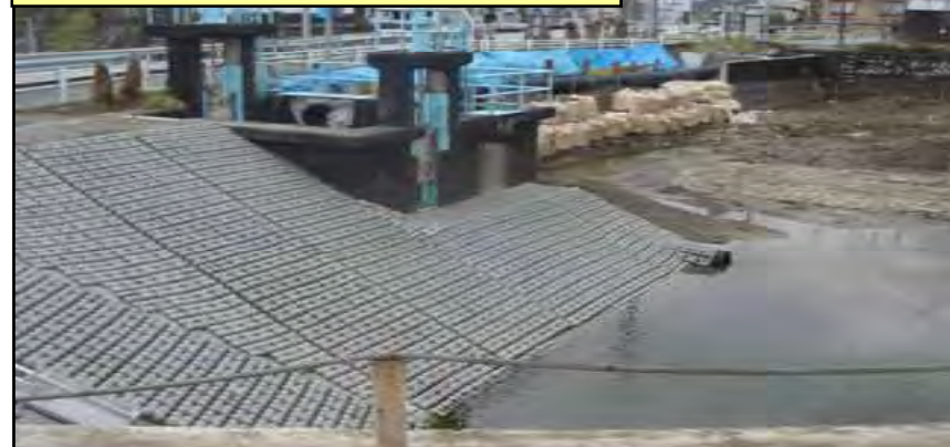
堤体内改良土の被覆(完成)
