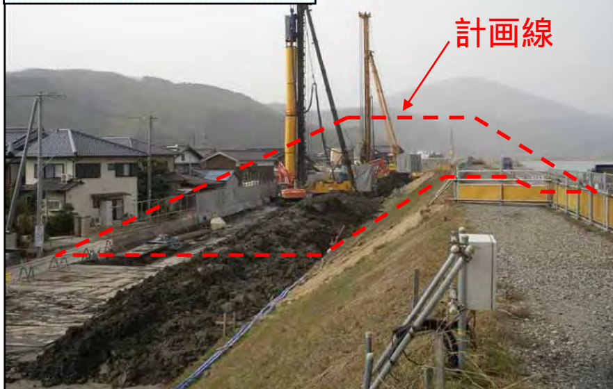
現場全景(着工前)
