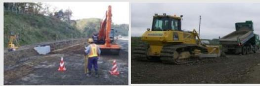
(バックホウによる法面整形) H23: 総CO<sub>2</sub>削減量: 約21t-CO<sub>2</sub> (8工事)
