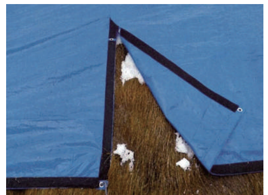
■マジックテープによる接合部
