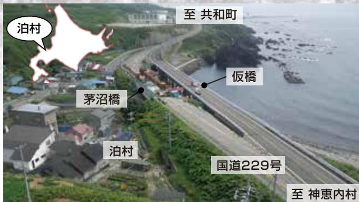
当初は現場製作主桁の計画でしたが、設計図書の照査によってプレキャストセグメント主桁の採用が可能であることを確認し、変更しました。
