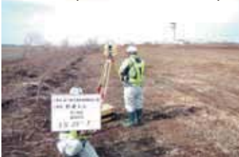
起工測量(レーザースキャナー)
