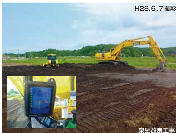
■ICT バックホウによる法面整形と内画面
