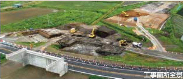
工事箇所全景
