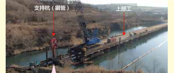
支持杭(鋼管)を先に打設し、杭頭キャップを介して上部工と連結(杭頭キャップ工法)
