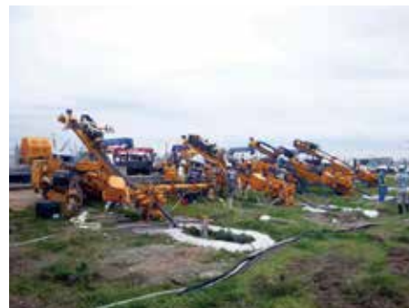
■曲がり削孔施工状況
