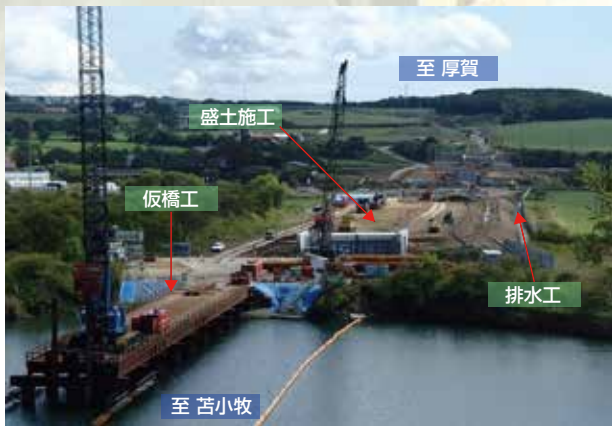
工事箇所全景(清島西工区)
