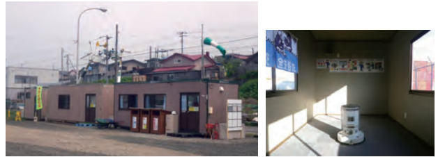
プレハブ休憩室の設置
