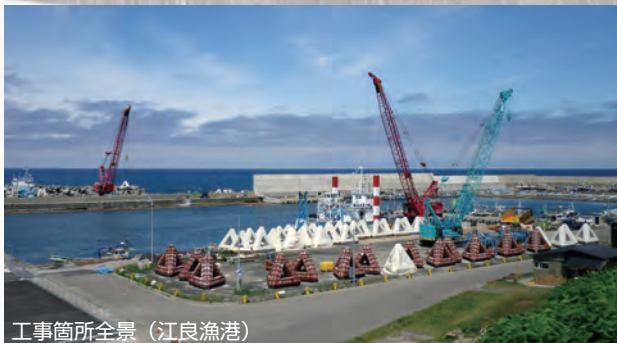
工事箇所全景 (江良漁港)
