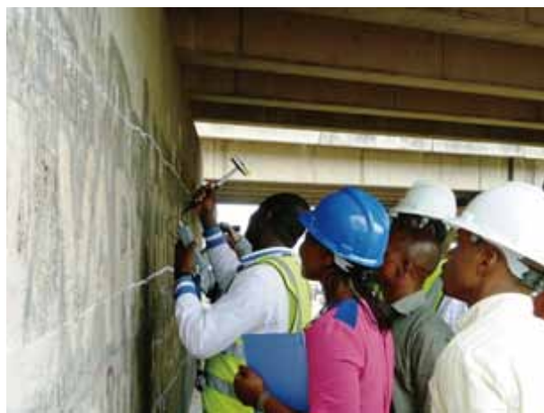
●橋梁点検の研修実施状況
