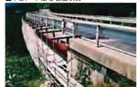
■H鋼アーム足場 設置状況
