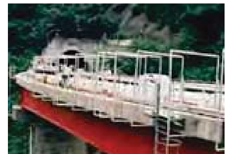
■単管フープ足場 設置状況
