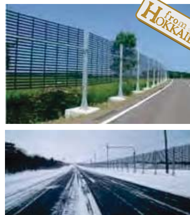
■ベルト式ネットフェンス 設置状況
