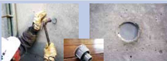
St コン (エステーコン：P コーン穴埋め処理材) 【新技術】NETIS 登録：KT-050007-V
