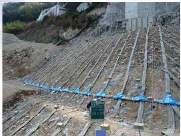
排水材・アンカーバー設置
