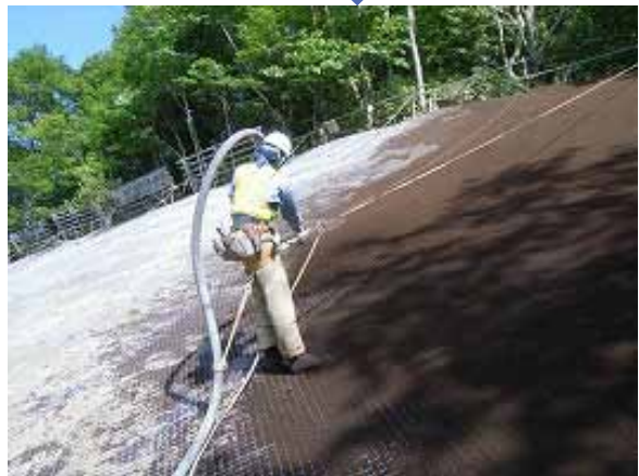
植生基材吹付
