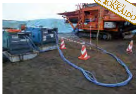
■新技術施工状況(全景)
