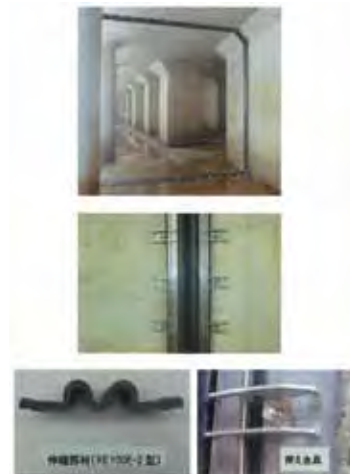
■RE-2型の設置状況と部材写真
