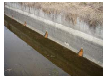
■ウィープホール機能再生ドレーン工法
