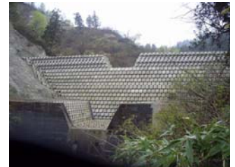
■コーケンブロック積えん堤工法
