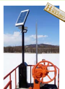
■省電力型太陽電池照明システム
