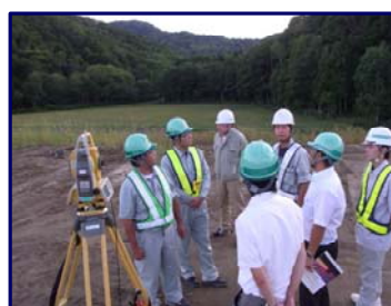
■現場説明状況
