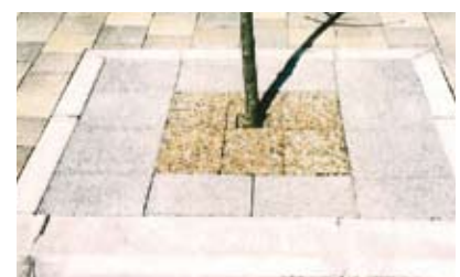
■植樹帯防草工施工例
