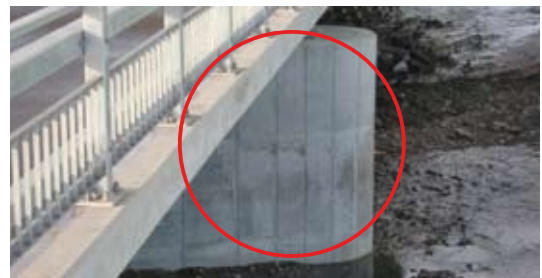
■施工後の奈井江橋橋脚 (本工法特有の目地密度の高さが伺える)
