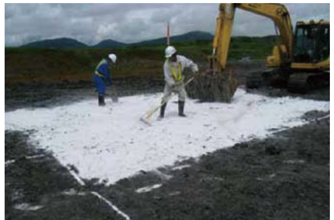
不溶化剤敷設状況
