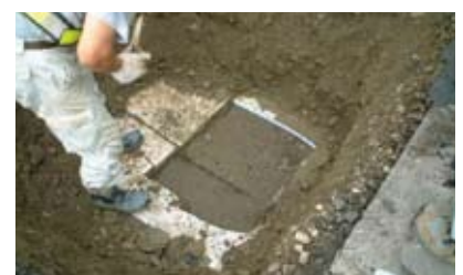
■断熱材採取状況
