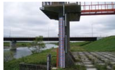
■フロート式洪水痕跡計設置全景
