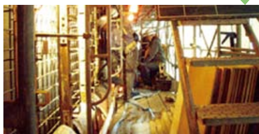
■コンクリート打設作業の状況
