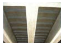
PC橋(間詰部補強)
