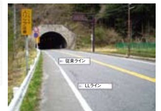
■L・Lラインの施工状況 (従来技術との比較)
