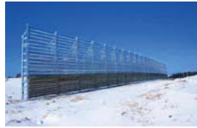
■景観に配慮した 吹き止め式防雪柵設置
