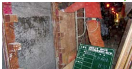
■型枠解体作業の状況
