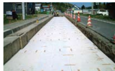
■断熱材の施工
