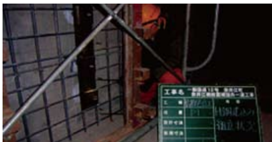
■H鋼組立作業の状況
