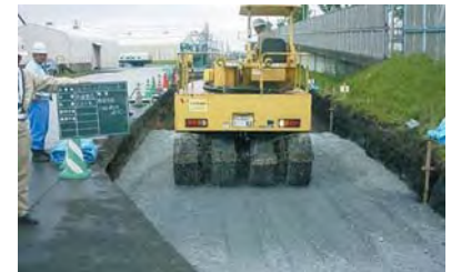
■路盤工施工状況
