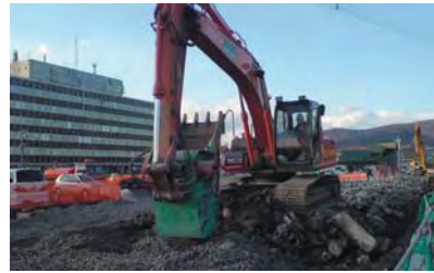
■コンクリート舗装版現場内骨材再生状況
