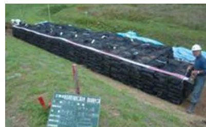
■袋詰め設置状況
