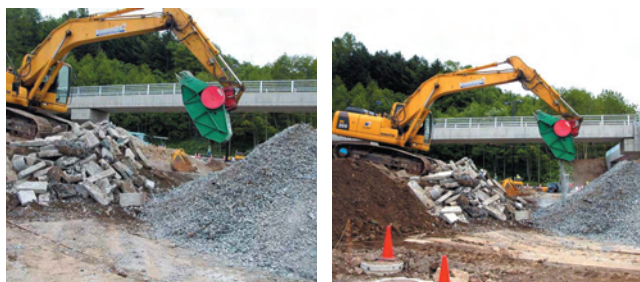
■園内駐車場舗装外一連工事における骨材製造状況 (開発会社HPより引用)
