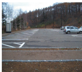
■製造した骨材が使用された 施工後の滝野の森口駐車場
