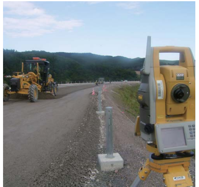
■情報化施工 グレーダのマシンコントロール技術（敷均し）
