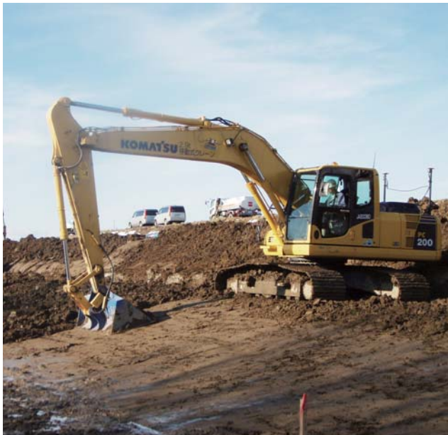
■ICTバックホウ 施工状況
