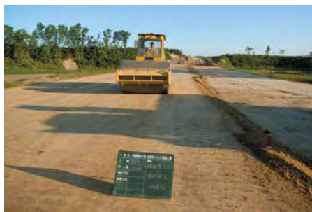
■締固め作業状況
