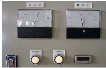
■100ボルト開閉機 試験用自動運転 制御盤
