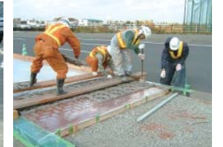
■インデスコ標準ツール型押し作業(北広島市)
