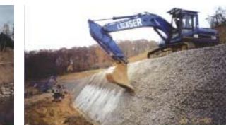
■バックホウによる砕石充填
