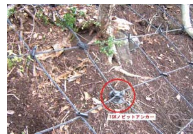
■TSKノビットアンカー設置(ロープネット工)
