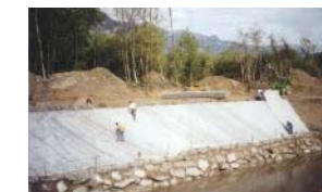
■不織布(吸出し防止材)と3Dパネルの設置
