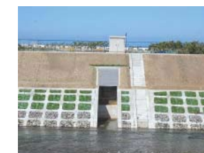
■小樽土木現業所 泊川高潮対策工事第2工区
