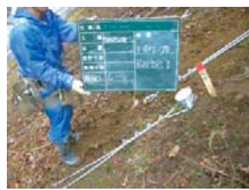
■アンカー設置後ロープ取付(雪崩予防柵)
