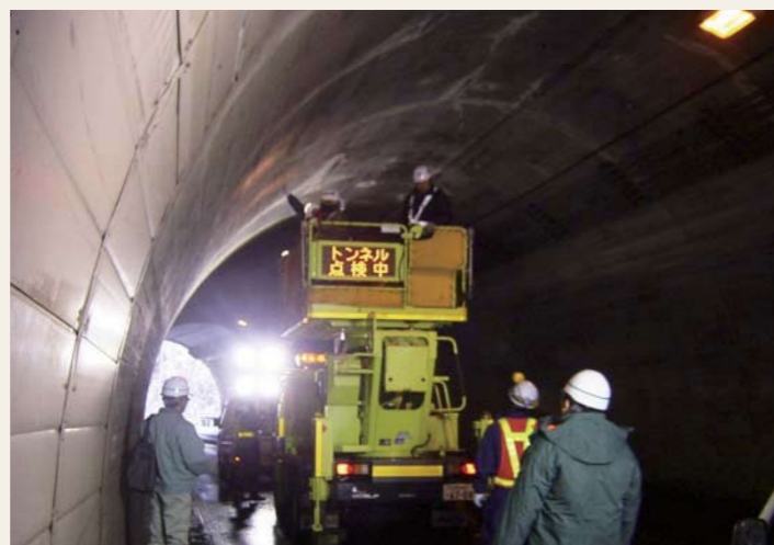
■トンネル点検車による点検状況
