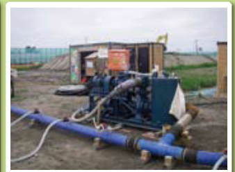
④ポンプ設置、ヘッダーパイプ接続
