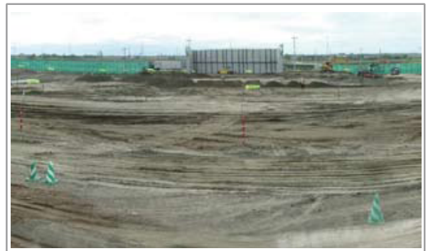
■施工写真（着工より5ヶ月経過）
