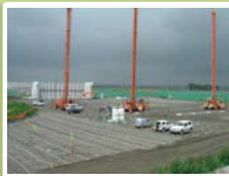
②鉛直ドレーン打設
