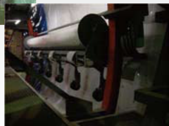
防水シート貼付部
