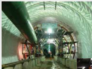
施工断面全景
