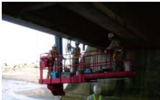
■橋梁下面からのコア試料採取
