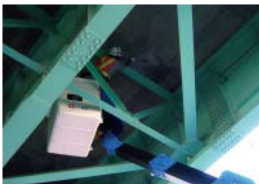
■ハンマーでの打音検査
