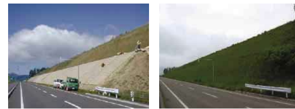
■ストローシート50施工直後 ■ストローシート50育成状況(2年後)
