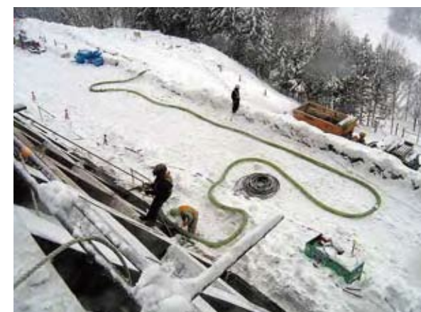
■厳冬期における吹付状況
