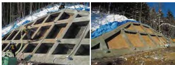
■吹付状況 ■吹付完了
