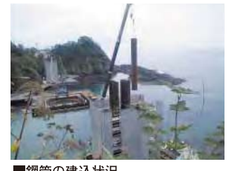
■鋼管の建込状況
