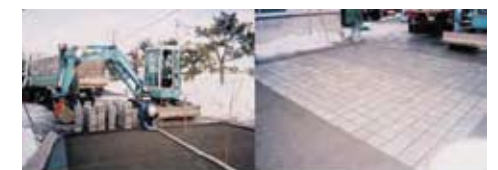
■施工状況及び完成後の状況
