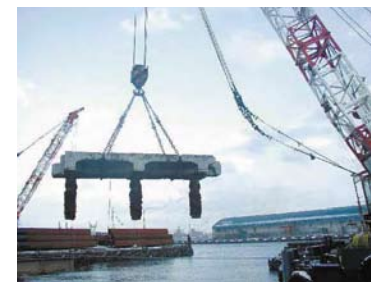
■吊り込み状況
