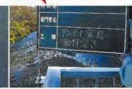
■アンテナ金具取付
