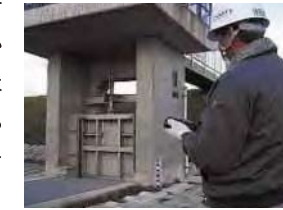
■扉体を見ながらゲートを操作
