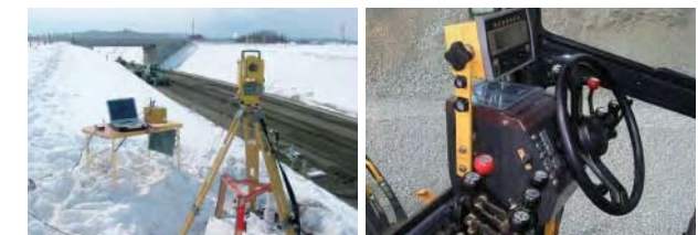
■モータグレーダとTSの設置状況 ■モータグレーダキャビン内の制御装置
