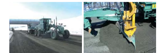
■モータグレーダによる作業状況と制御されるブレード部分
