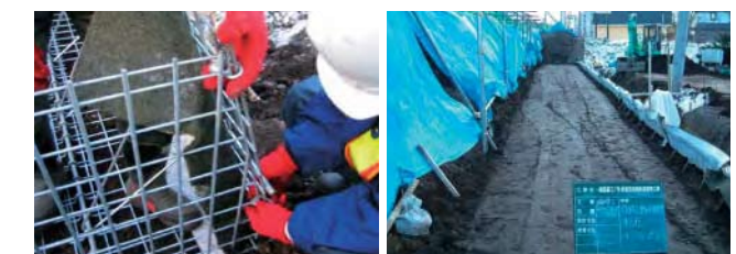
■KEパネルの組立作業とシートによる水対策
