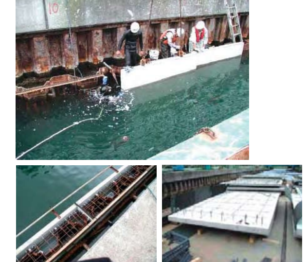
■パネル設置状況
