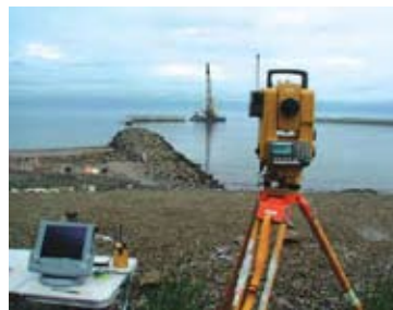
■施工観測状況
