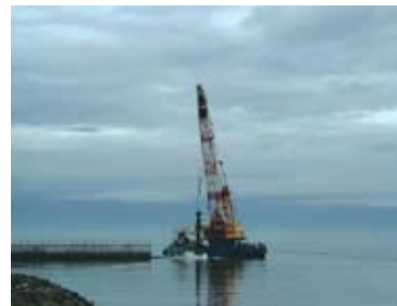
■水中基礎捨石均し作業状況
