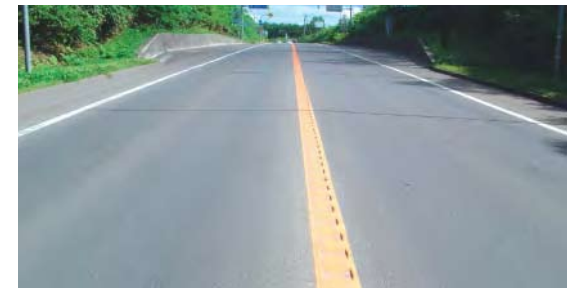
■「ランブルストリップス」の完成写真 「小樽開発建設部管内 道路区画線設置工事(小樽開発建設部 岩内道路事務所)」
