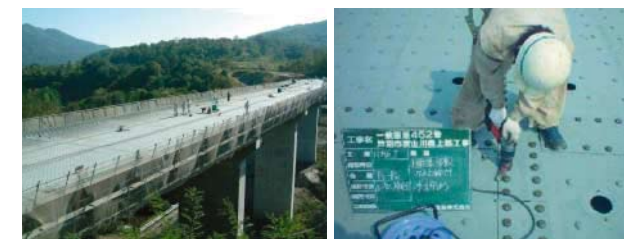
■床版設置の完了状況
