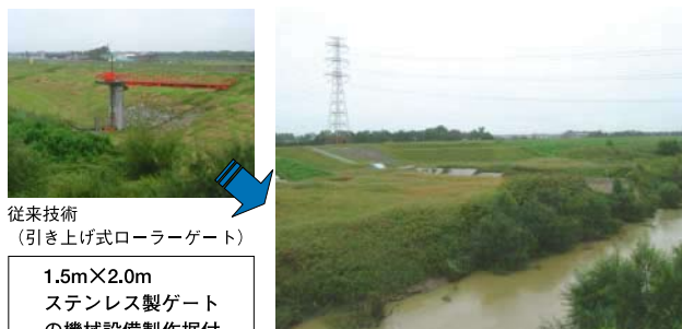
■オーバーリンクゲート設置外観
