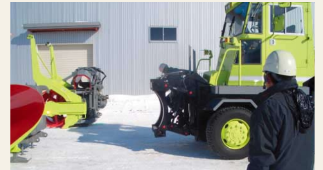
■写真-3 スノープラウとロータリ装置の交換作業状況
