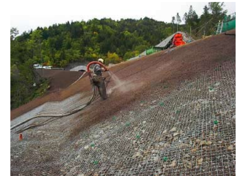
■「植物誘導吹付工」の施工状況 「一般国道333号 北見市 北仁法面工事 (網走開発建設部 北見道路事務所)」
