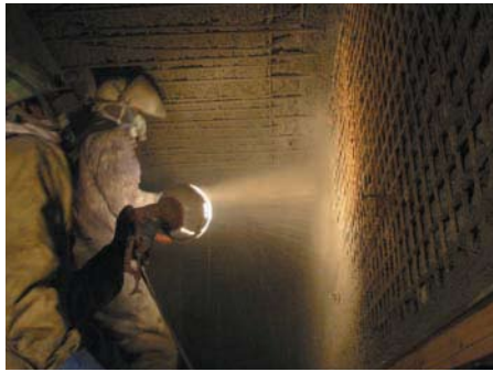
■アラミドメッシュ上へのコンクリート吹付け
