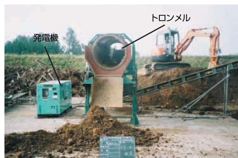
■トロンメルを使用したスキ取り物選別作業状況
