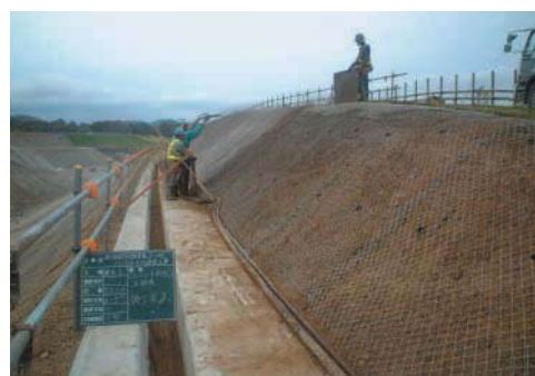
■厚層基材吹付状況
