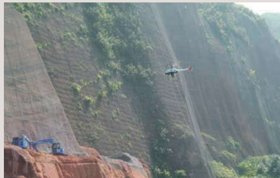
■写真-4 急崖法面調査への活用
