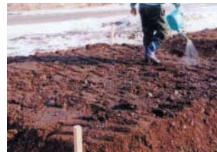
■液状凍結防止剤散布施工
