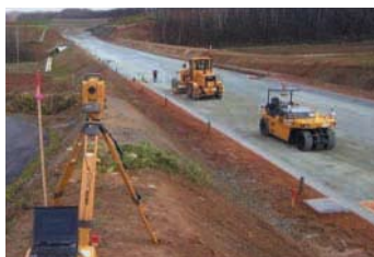
■3D-MCモータグレーダによる作業状況
