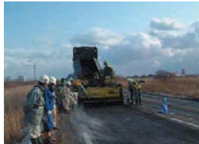
■施工状況(北海道苫小牧市)
