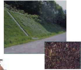
■チップバック植生工法(土砂系)育成状況
