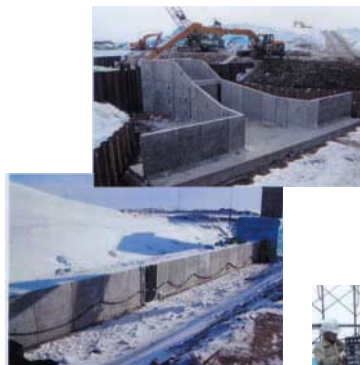
■石狩川中島樋門(弾性接合方式、オールプレキャスト)
