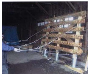
■支持ロープ設置状況
