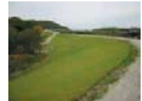
■施工実績(春日築堤)
