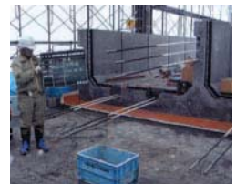
■アイボンドPC鋼棒挿入状況
