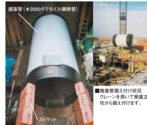
■推進状況 元押しジャッキと推進管との間にストラットを設置し、徐々に推進していきます。
