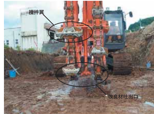
■ベースマシンに取り付けられたトレンチャー部
