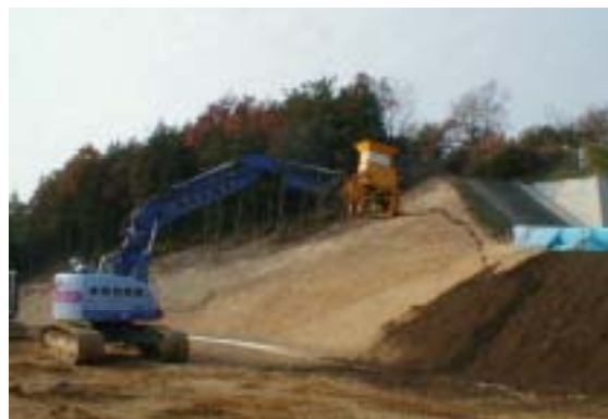
図 - 3.6 撒きだし工
