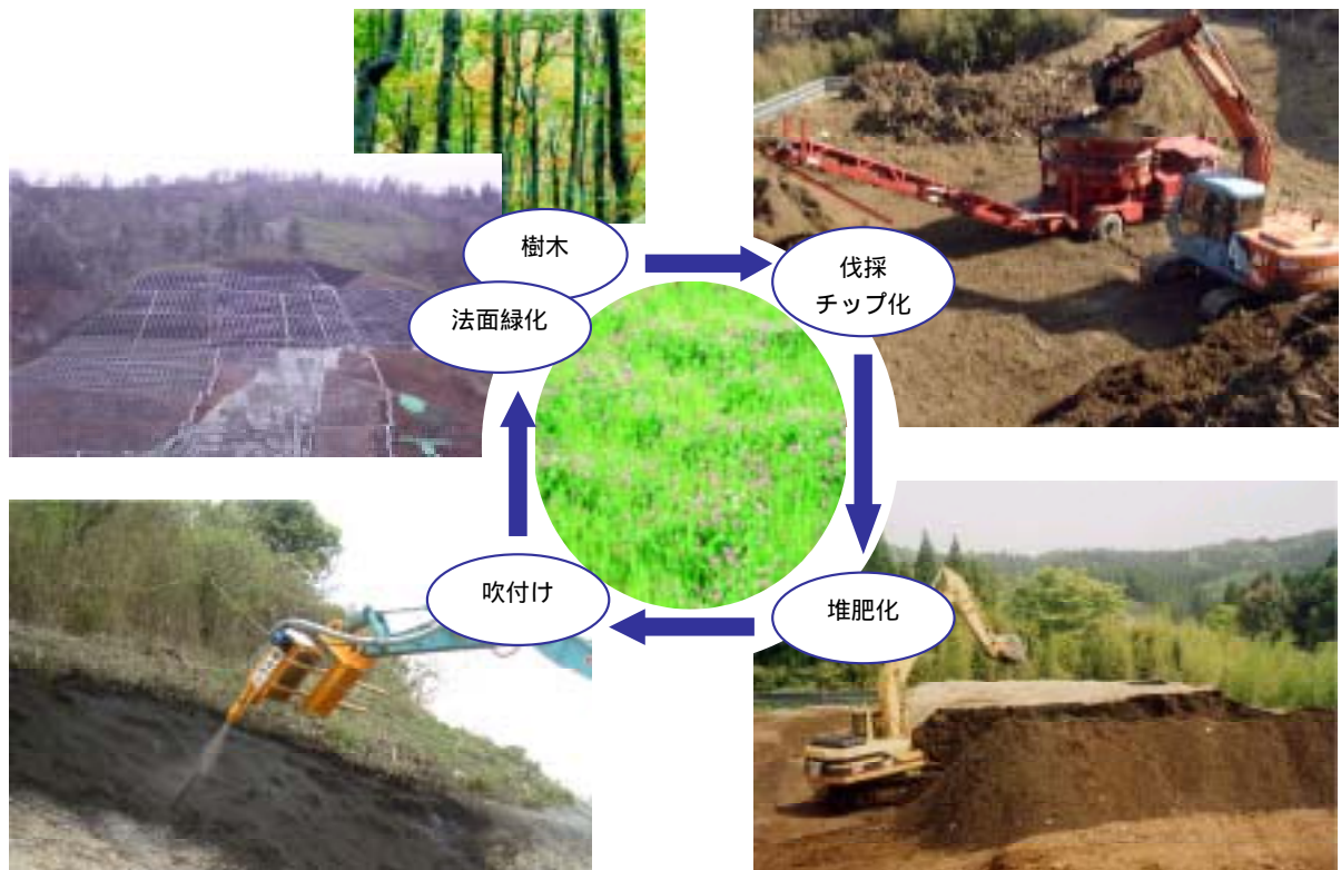
図 - 3 . 7 破碎後堆肥化して法面緑化材等としての利用状況
