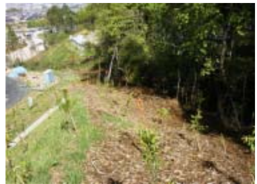
図 - 3.2 法面肩部のマルチング状況
