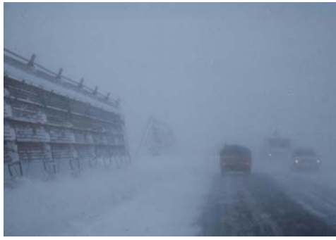
防雪柵 (吹き払い柵)
