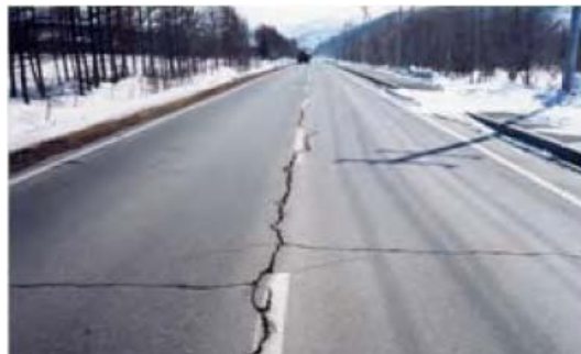
凍上による舗装のひび割れ
