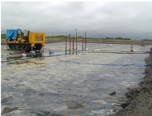
圧密促進工法
