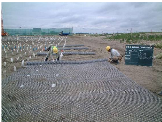
圧密促進工法
