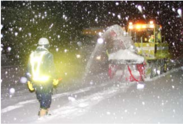
歩道部の除雪
