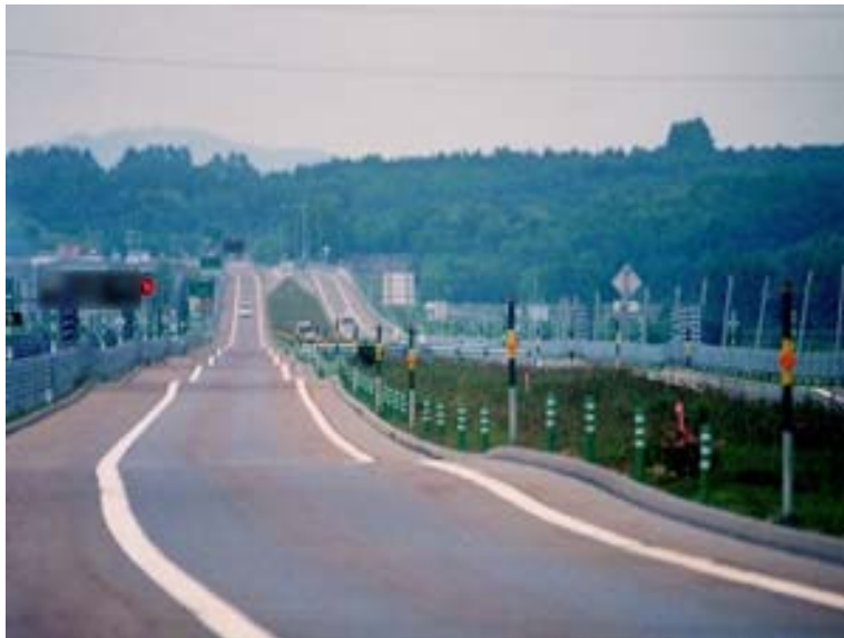
泥炭性軟弱地盤における長期沈下
