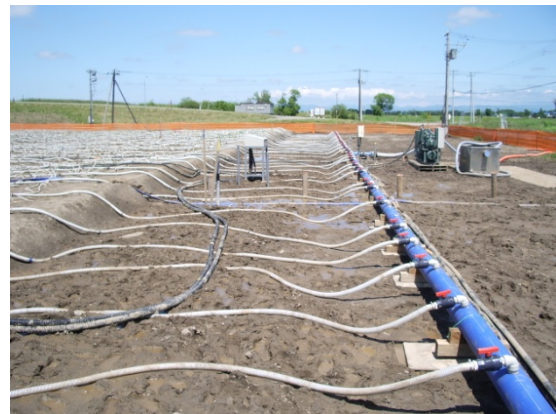
圧密促進工法
