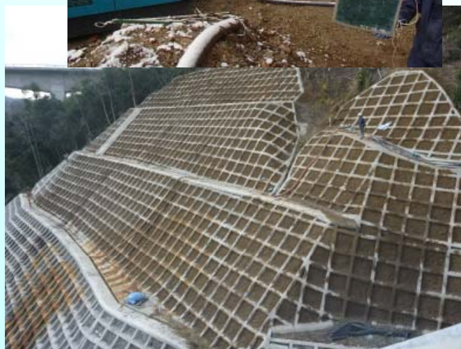
高所施工システム （ポンプ圧送方式）
