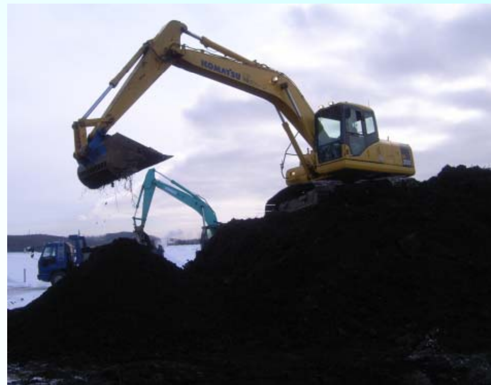
現地発生土・篩分け
