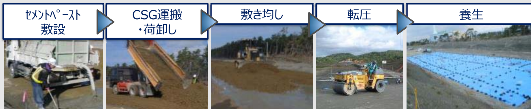
写真 CSG工法による施工の流れ
