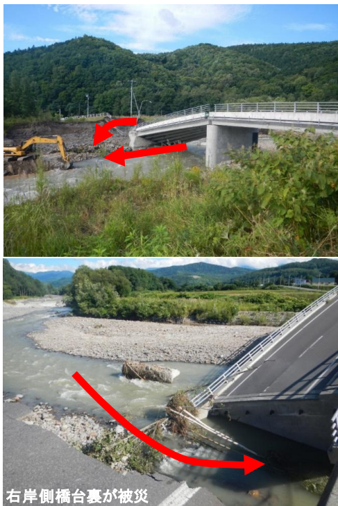
図-22 H28.8出水における橋梁被災状況（辺別川九線橋）
