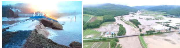
写真-1 河川の被害状況 (左:常呂川、右:石狩川水系空知川)
