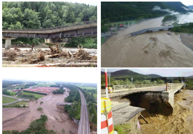
写真-2 主な道路橋梁の被災状況 (左上:国道273号 高原大橋、右上:国道274号 千呂露橋、 左下:国道38号 小林橋、右下:国道38号 太平橋)
