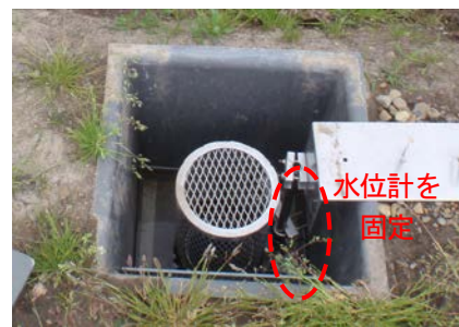
図-3 地下灌漑用の取水柵（集中管理孔）に設置した水位計円筒型メッシュスクリーンの下に暗渠管がある。
