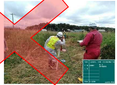
監督職員、現場技術員の臨場写真
