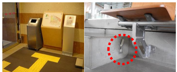
視覚障害者誘導用ブロック、点字による案内板の設置
